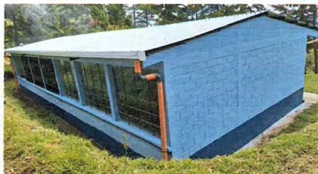
Foto 2: ÁREA DE LA PARTE DE ATRÁS DONDE SE REALIZÓ EL MEJORAMIENTO DE TECHO, MANTENIMIENTO DE COSTANERAS Y MEJORAMIENTO DE CANALETAS CON SU RESPECTIVA CAIDA DE AGUA FINALIZADO.
