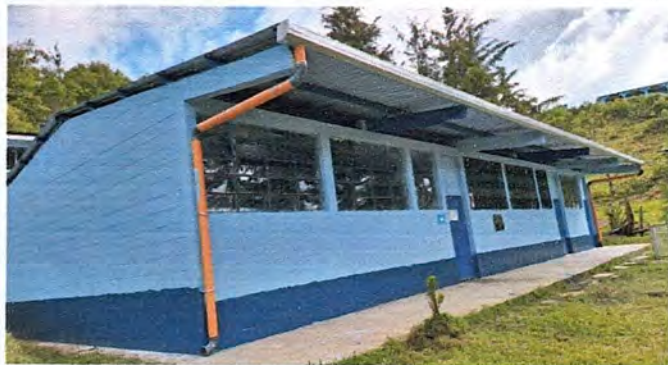
Foto 1: ÁREA FRONTAL DONDE SE REALIZÓ EL MEJORAMIENTO DE TECHO, MANTENIMIENTO DE COSTANERAS Y MEJORAMIENTO DE CANALETAS CON SU RESPECTIVA CAIDA DE AGUA FINALIZADO.
